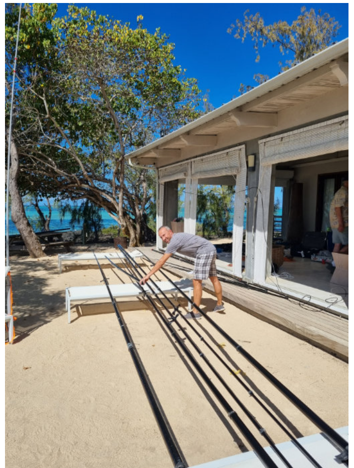
Denny, KX7M, bei Antennenbauarbeiten.
