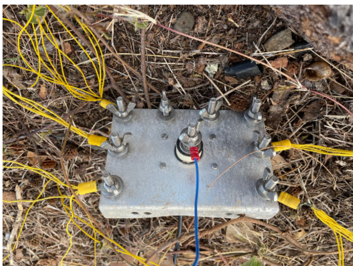
Die Einspeisung der 160m-Vertikal. 2023 gibt es noch mehr Radials.
